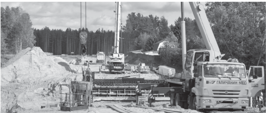
Реконструкция дороги Олонец – Вяртсиля. Фото: «Республика»/Лилия Кончакова
